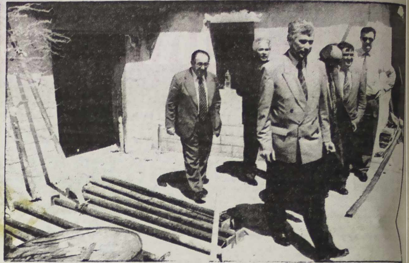
Zašto obnova obiteljskih kuća u Drnišu i okolnim naseljima ne teče planiranom dinamikom? Problem je u tomu što nema dovoljno građevinskih radnika, ustvrdio je dr. Jure Radić i najavio dolazak nekoliko stotina radnika koji poslove obnove u zapadnoj Slavoniji završavaju ovih dana. Neka od poduzeća koja rade na poslovima obnove obiteljskih objekata nisu se dovoljno intenzivno uključila u posao. To je razlogom što će njima biti smanjen opseg posla, a novih potpisivanja ugovora s takvim građevinskim poduzećima neće biti, kazao je među ostalim dr. Radić
