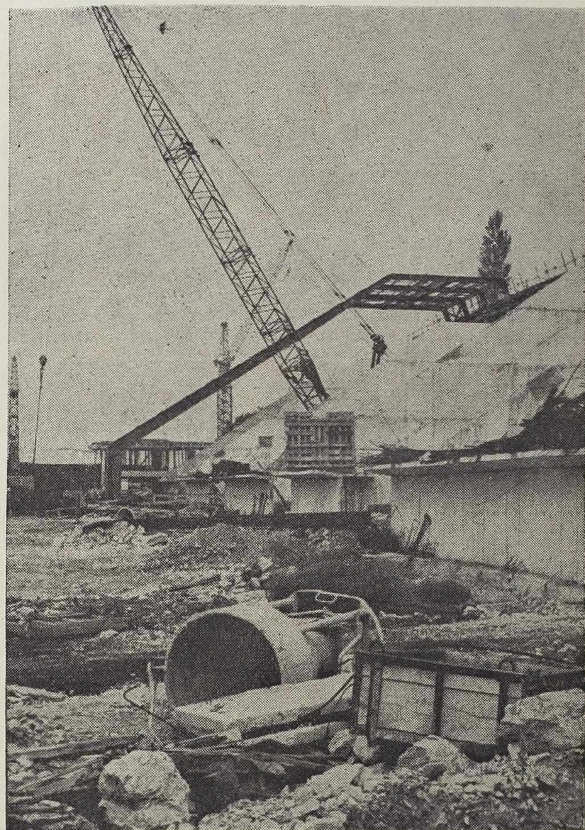
Terminal u luci još je uvijek u gradnji
