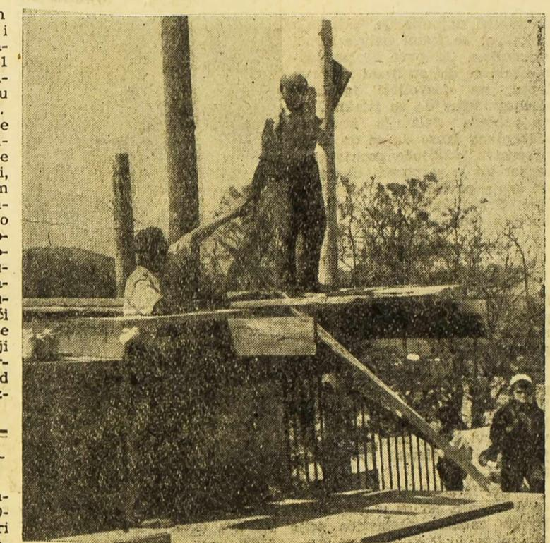
Konačno, dovršavaju se posljednji radovi oko uređenja stupa i prilaza katedrali sa njenog pročelja. Na vrhu lepezačkog stepeništa, na kraju potpornog zida, postavljena je skela radi pozicioniranja kamenog stupa, koji će se dizati nad bazom od velikog ugaonog kamena.
