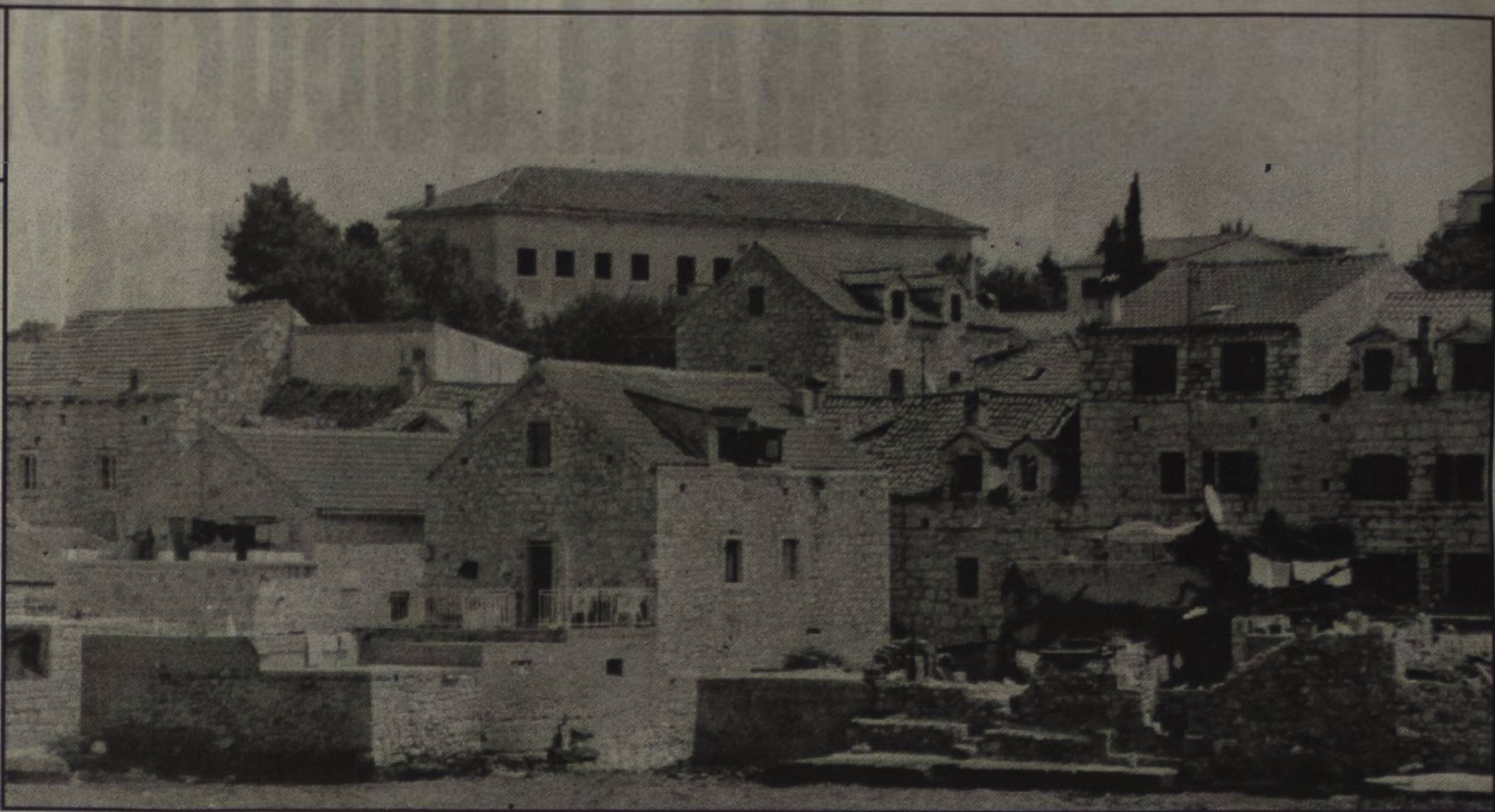
Krov stare devastirane škole nadvisuje Šepurine — i tu zgradu, kako saznajemo, želi kupiti Gorislav Vlahov
