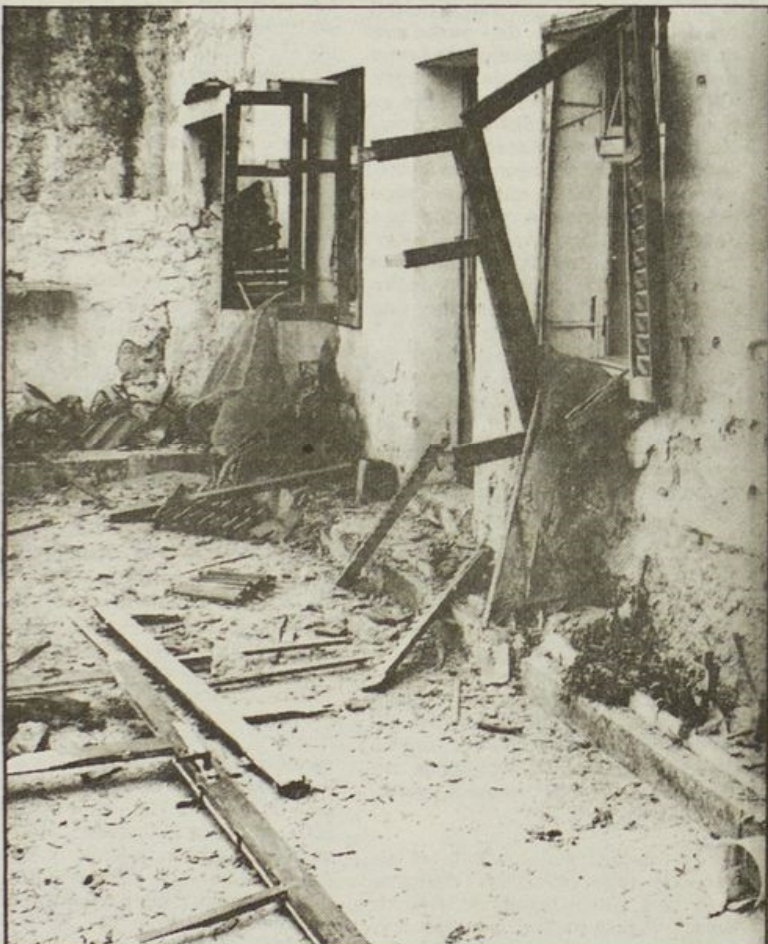
Još jedna obiteljska kuća znatno je oštećena u posljednjim napadima na Vodi-ce. Srećom, stradalih nije bilo
